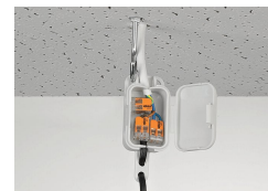
天花板吊灯接线
